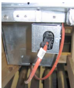
Figura 6: Conecte los conectores blancos de dos clavijas y enchufe el conector negro en la caja eléctrica como se muestra. * Tome en cuenta la posición de que el conector negro puede diferir de la foto.
